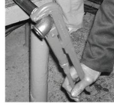
Ek parçasının boruya sıkılması
