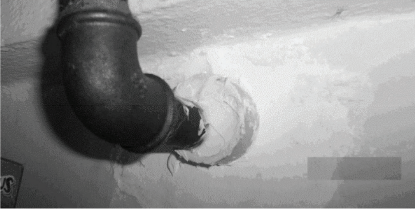
Şekil 20 Duvardan Kılıflı Boru Geçirme
