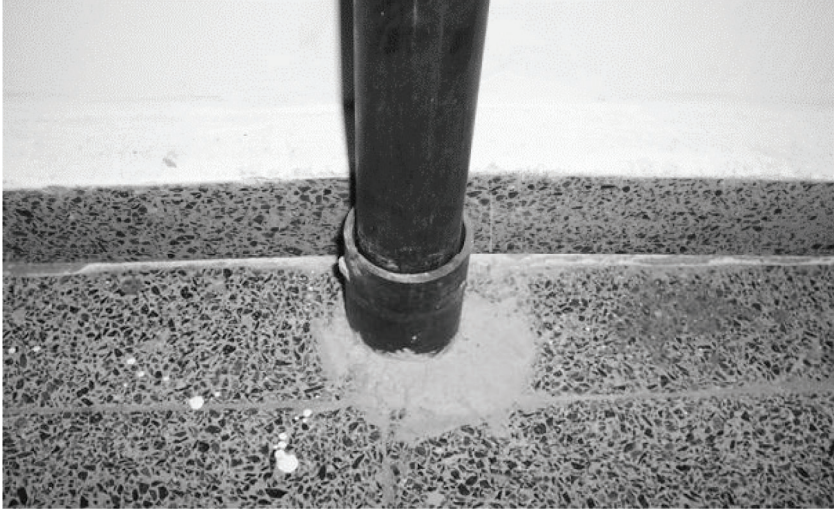
Şekil 19 Döşemeden Kılıflı Boru Geçirme
