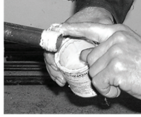
Boru ve ek parçasına macun sürülmesi
