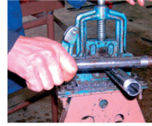
Diş üzerindeki çapakların temizlenmesi
