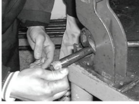
Boruya keten sarılması ve macun sürülmesi
