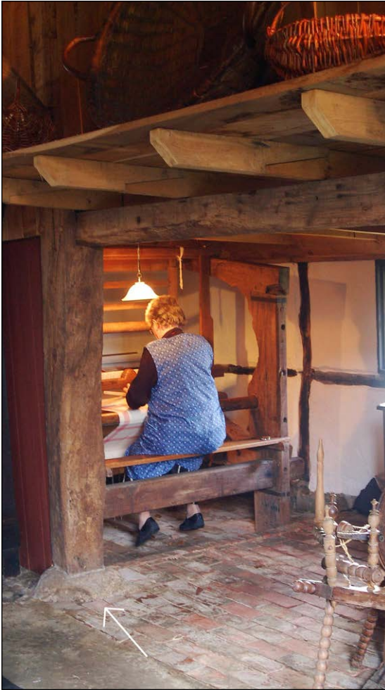
Afb. 91 Een weefster aan het werk in het Twentse Los Hoes (bron: canonvannederland.nl). De dakdragende stijlen rusten op natuurstenen stiepen.
