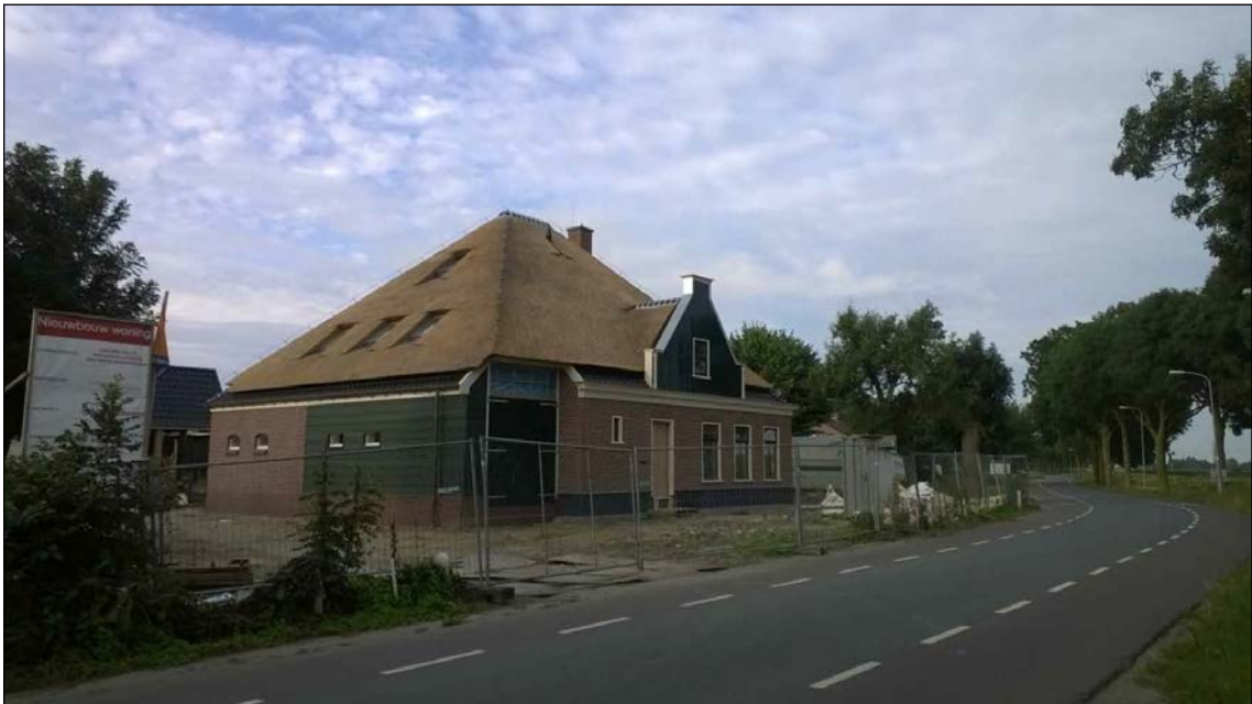
Afb. 100 De herbouw van Binnenwijzend 100 is in augustus 2014 in volle gang.
