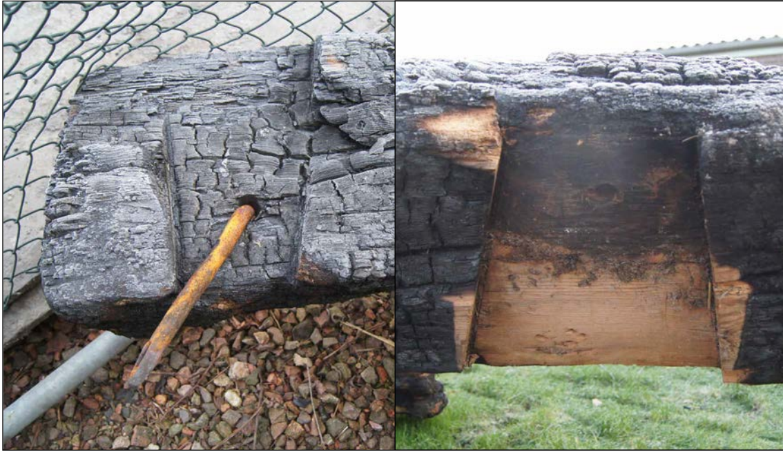
Afb. 51 Zwaluwstaartvormige inkepingen aan de onderzijde van bovenste dekbalken.
