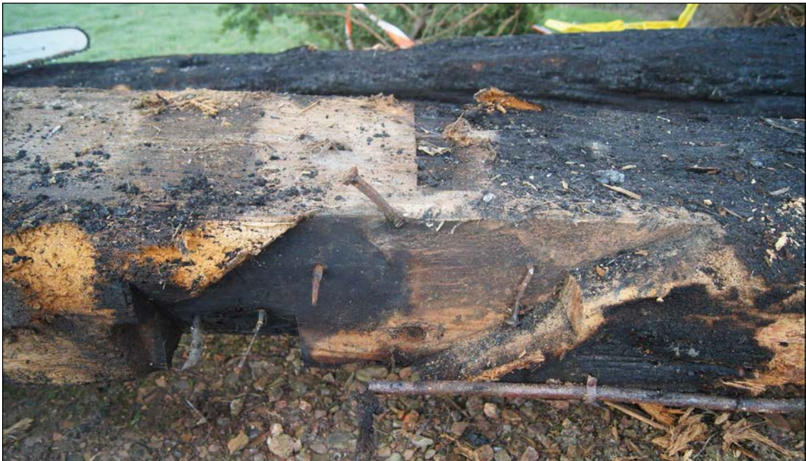
Afb. 53 Een schuine inkeping met hak voor een zwing. Linksonder is bovendien een schuine inkeping aanwezig van een tilbalk.
