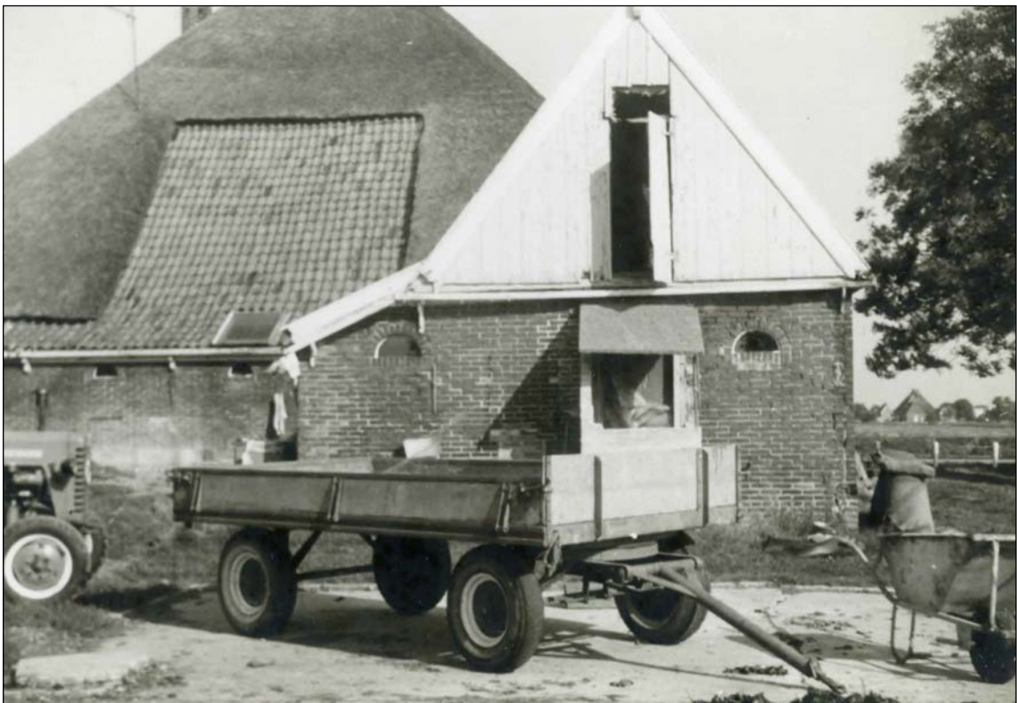
Afb. 43 De achterkant van de boet en de achtergevel van de stolph met de dakspiegel. Tegen de achterzijde van de boet staat de wc. Foto familie Zwaan.
