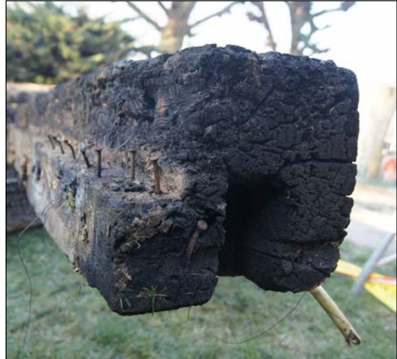
Afb. 59 De kop van een eiken balk met een half weggezaagde inkeping van een pen-en-gatverbinding.
