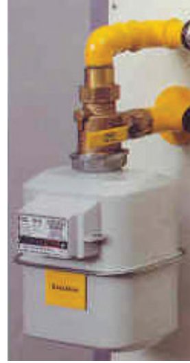
Şekil 3.1. İki ve Bir Bağlantılı Körüklü Sayaç
