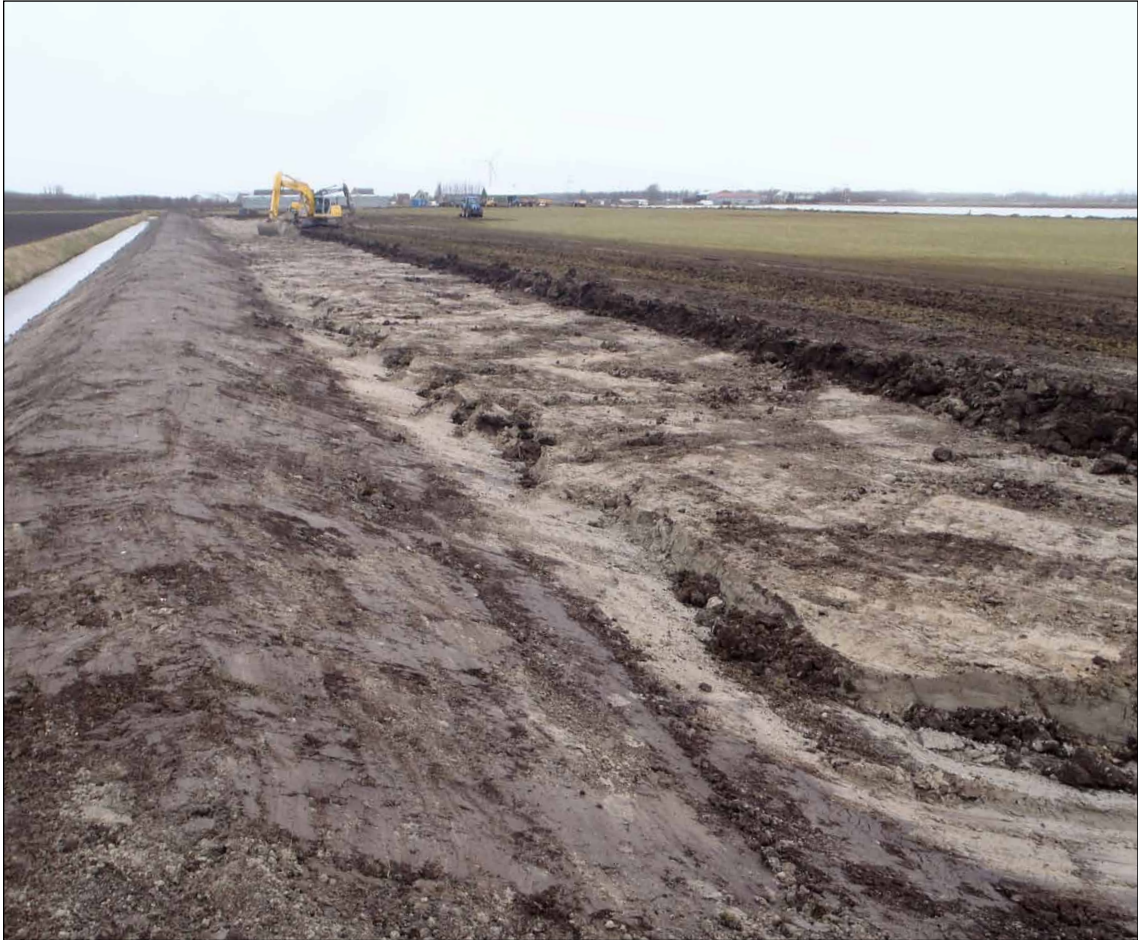
Afbeelding 15. Kooiland. Werk in uitvoering. De teelaarde wordt in lange stroken verwijderd en afgevoerd.
