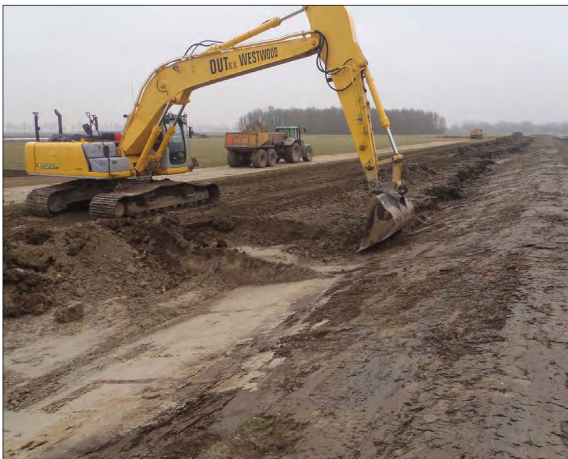
Afbeelding 14. Kooiland. Met behulp van grote 27 – tons kranen word rondom het terrein een aarden wal aangelegd.
