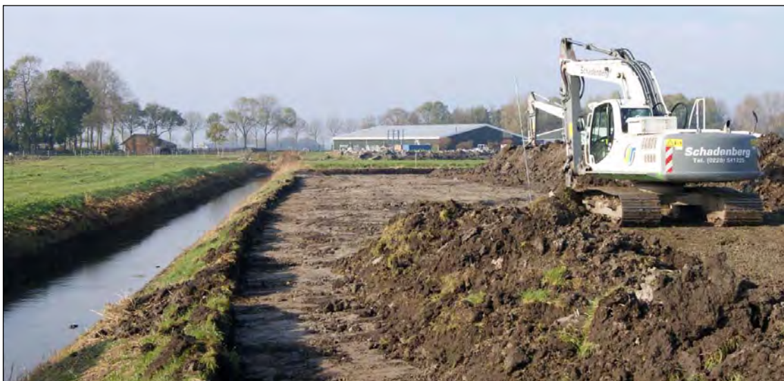
Afbeelding 6. Blokdijk. Met behulp van een grote 27-tons kraan wordt de teelaarde afgegraven.
