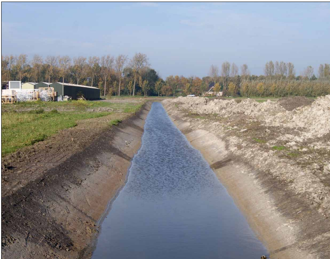
Afbeelding 8. Blokdijk. Nieuw gegraven sloot. In het schuine talud aan weerszijden van de sloot zijn diverse sloten uit de Middeleeuwen en Nieuwe Tijd aangesneden. De smalle sporen zijn moderne drains.
