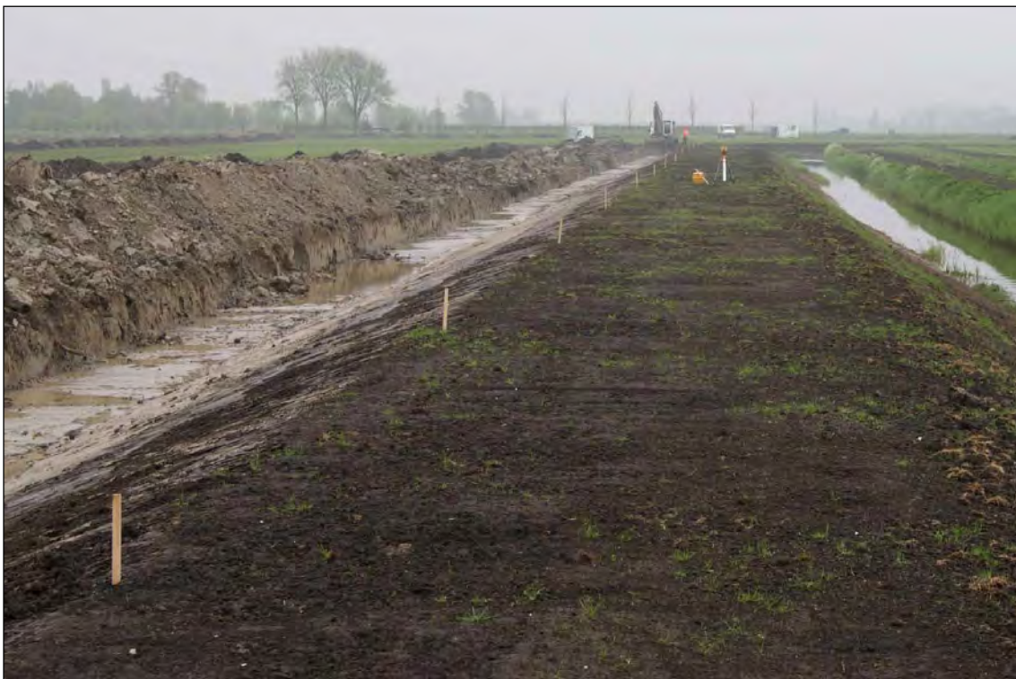
Afbeelding 11. Burg. J. Zijpweg. Rondom het terrein van de geplande waterberging werd een aarden wal of kade aangelegd. In de profielen van de sleuf naast de wal konden de aanwezige sporen binnen het plangebied worden geïnventariseerd.
