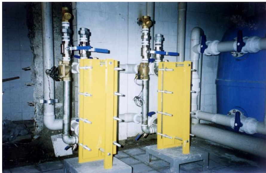
Paralel bağlanmış iki ısı eşanjörü :
