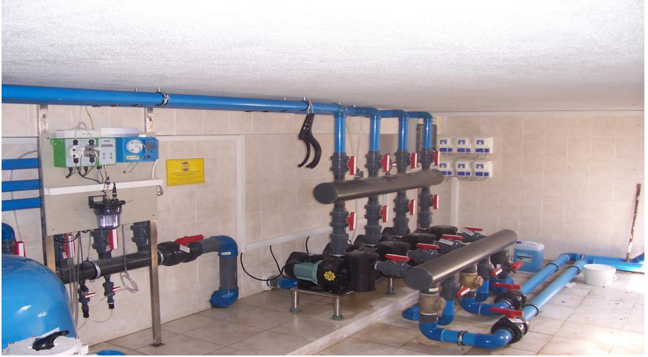
Fotoğraf : 19.1.4 de GÖRÜLEN POMPALARLA DONATILMIŞ BİR MAKİNA DAİRESİ ,
