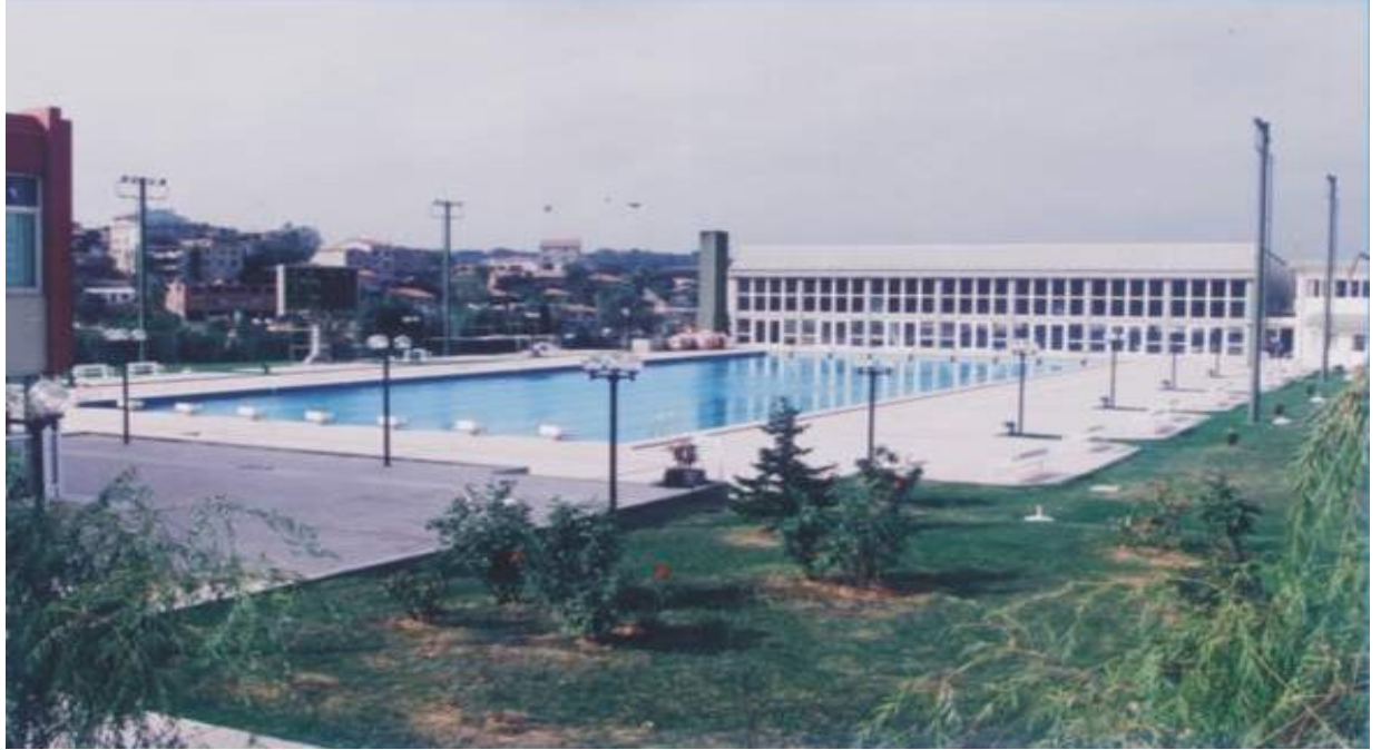
İstanbul Sadi Gülçelik spor tesisi açık yüzme havuzu
