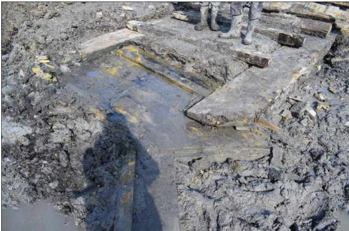
Afb. 4.50. De zandstrook lag op een inkeping van de houten funderingsvloer van de vijzelbak.
