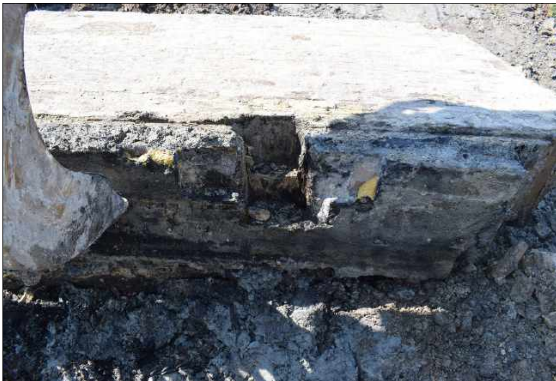
Afb. 4.39. In de onderzijde van de vijzelbak waren sponningen gemaakt om de kespen en zwalpen te bevestigen.
