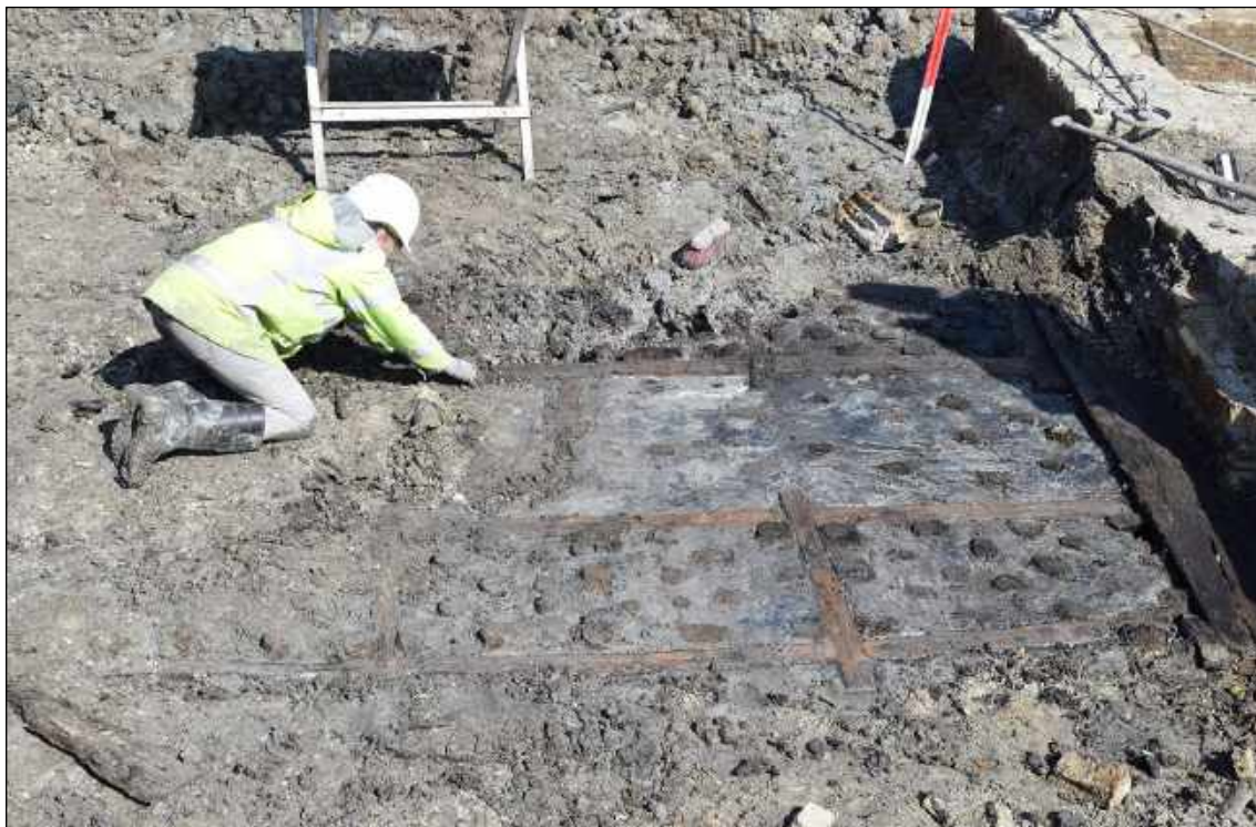
Afb. 4.22. De roosterfundering van de voorwaterloop van de poldermolen. Rechts is nog een plank zichtbaar van het plankier van de bakstenen vloer van de voorwaterloop.
