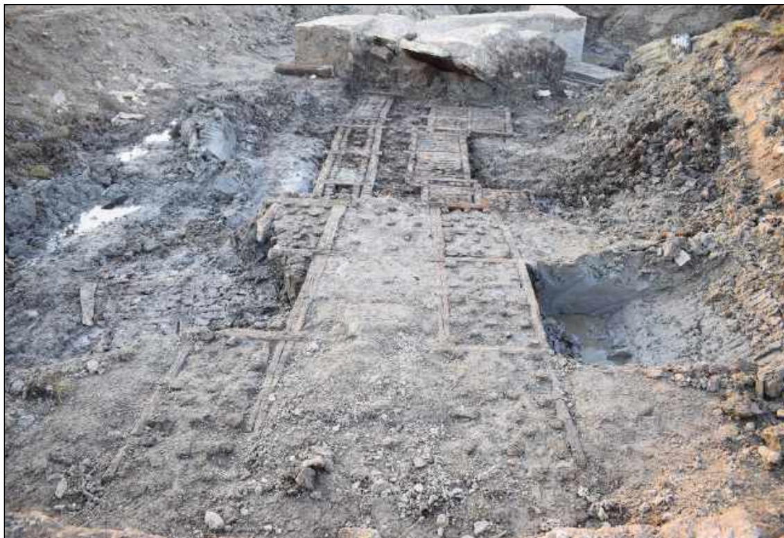
Afb. 4.24. Aan de linkerkant is zichtbaar dat een deel van de roosterfundering is weggebroken. Mogelijk hangt dit samen met de verbouwingswerkzaamheden ten tijde van de vervijzeling.
