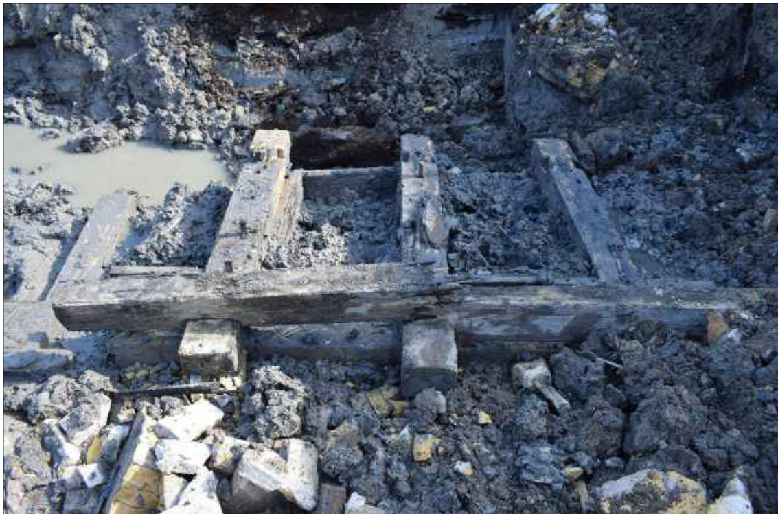
Afb. 4.49. Detail van de hoger liggende houten fundering van de vleugelarm met de halfhoutverbindingen.
