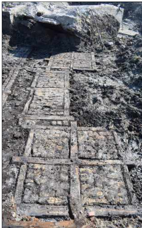
Afb. 4.18. De roosterfundering van de westzijde van de krimp met de twee penanten.
