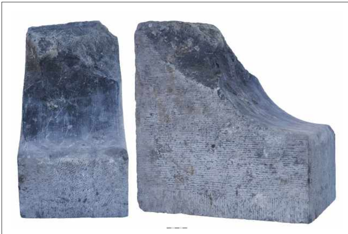
Afb. 4.53. De pensteen die onder de fundering van de vleugelarm werd aangetroffen (16-S01).
