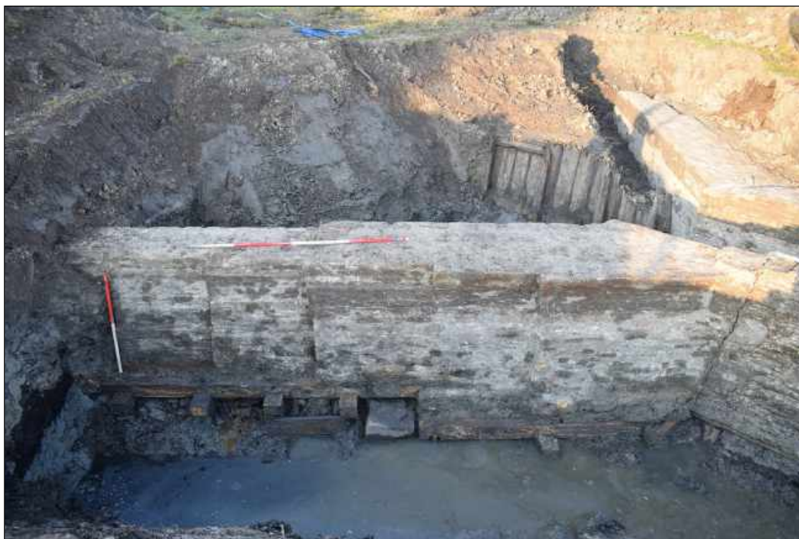
Afb. 4.51. Zijaanzicht van de vleugelmuur waarop de bouwwijze van de vleugelmuur en fundering zichtbaar is.
