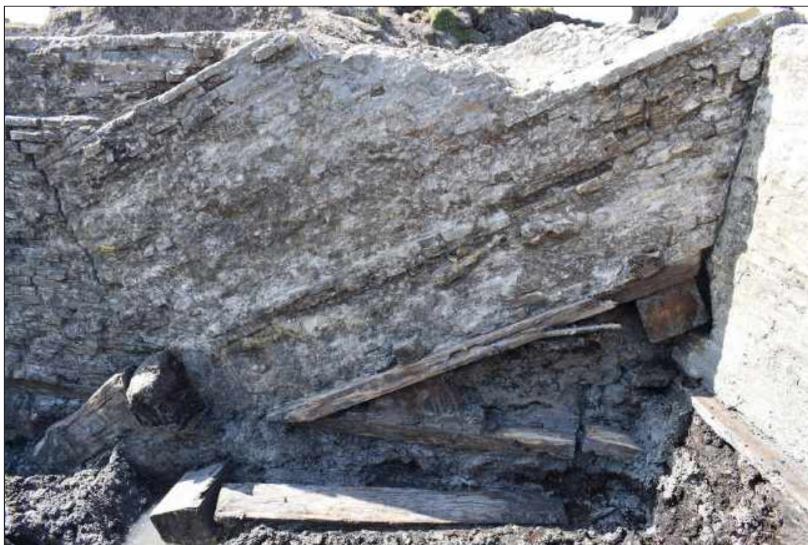
Afb. 4.45. Zijaanzicht van de vijzelkolom.
