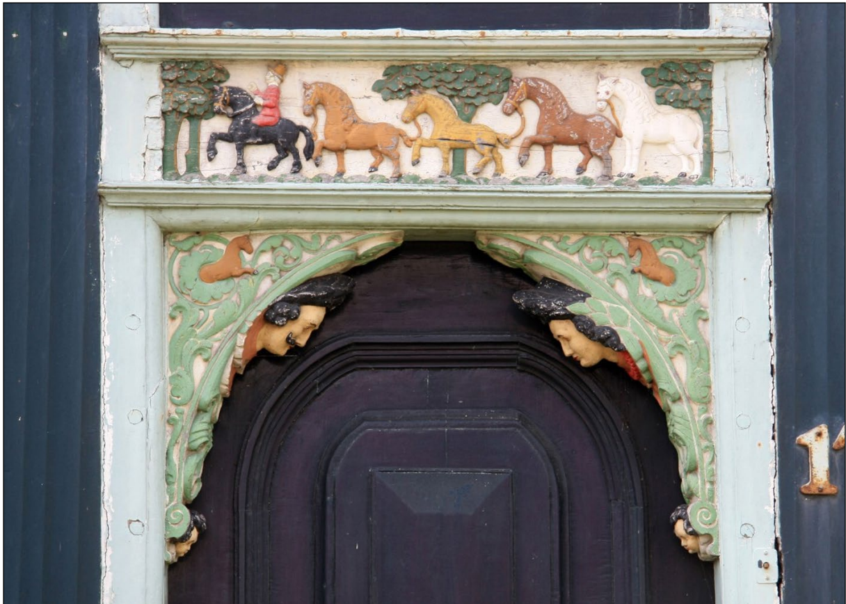
Voordeur van de rijksmonumentale stolpboerderij de Willemshoeve in Hoogwoud.
