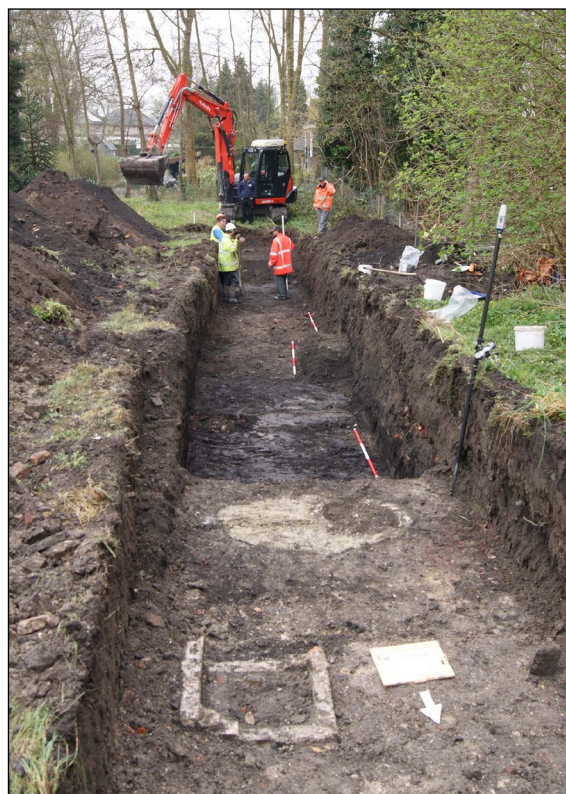
Afb. 3.1. Aanleg van de sleuf ten behoeve van de asbestinventarisatie.
