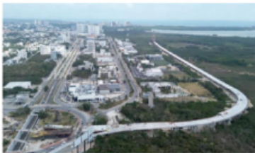
EL PUENTE reducirá el tiempo entre el aeropuerto de Cancún y la zona hotelera.
