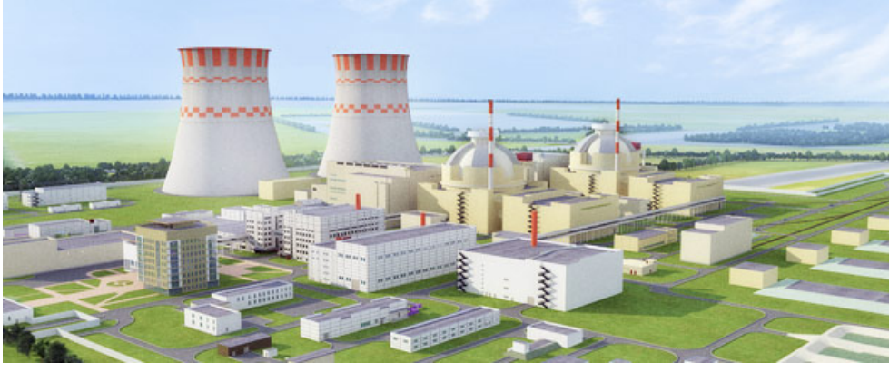
Şekil 8. İnşa aşamasında olan VVER-1200 tipi Novovoronezh II'nin 1 ve 2 nolu nükleer reaktörlerinin tasarım görünümü 100
